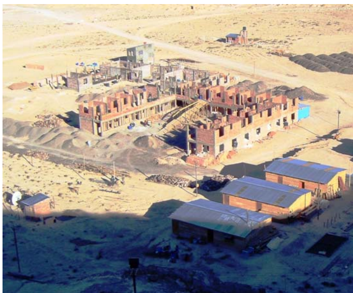
Campamento de la Planta Piloto en construcción
